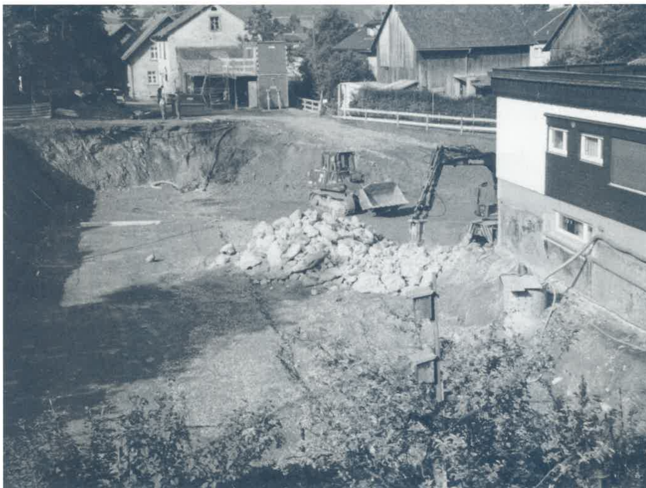
Am 9. Juni 1992 wurde der Specki-Koloss mit schwerem Gerät zertrümmert. Blick von Thomas Wangers Elternhaus nach Süden auf die Baugrube und dem zertrümmerten Specki-Koloss.
